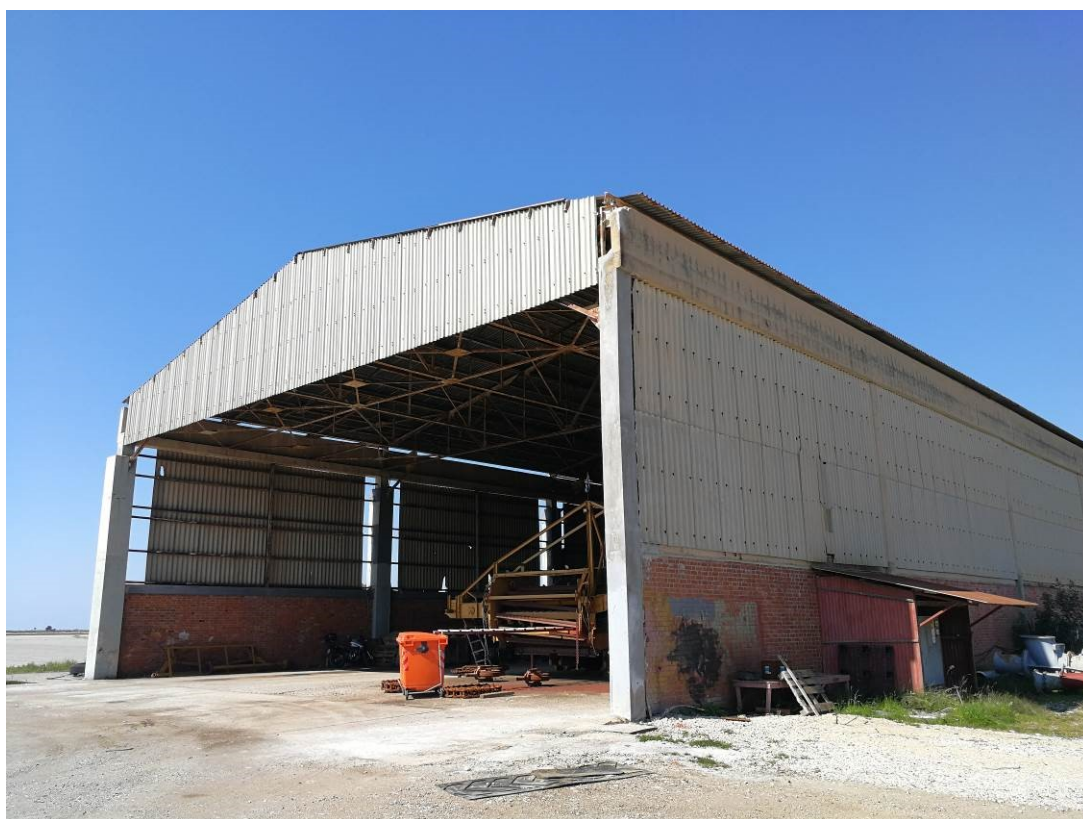
Άποψη του Υπόστεγου Οχημάτων.
